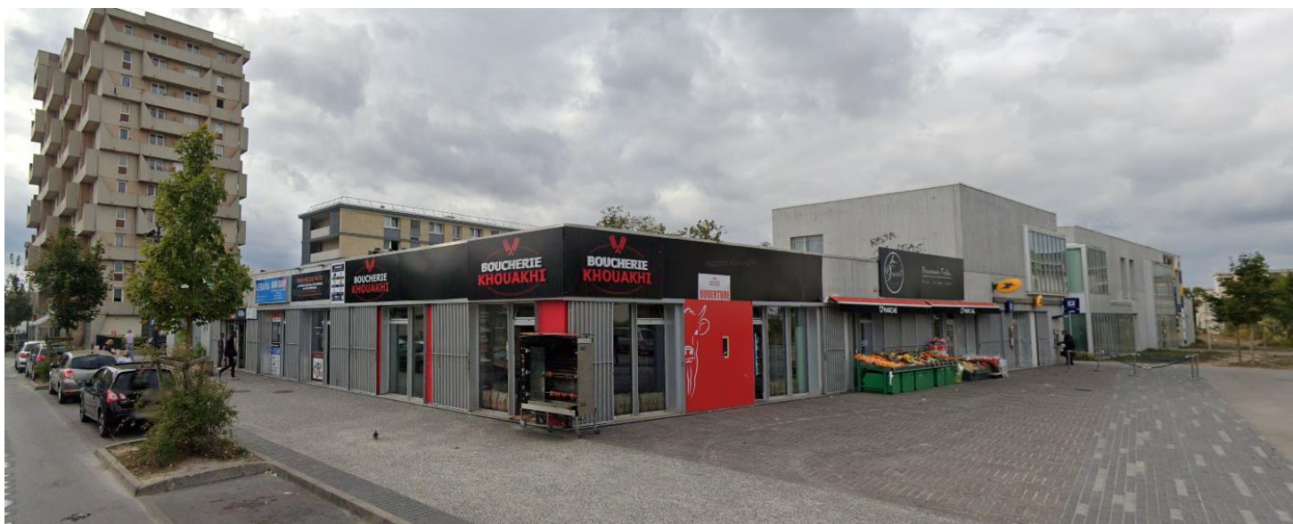
Le nouveau centre commercial Dunant
